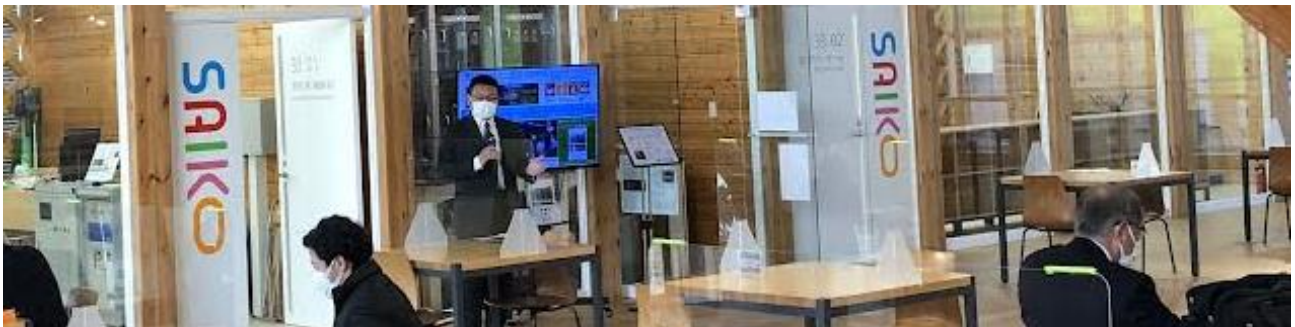
写真 3：レドックスフロー蓄電池による館内証明の実証実験
